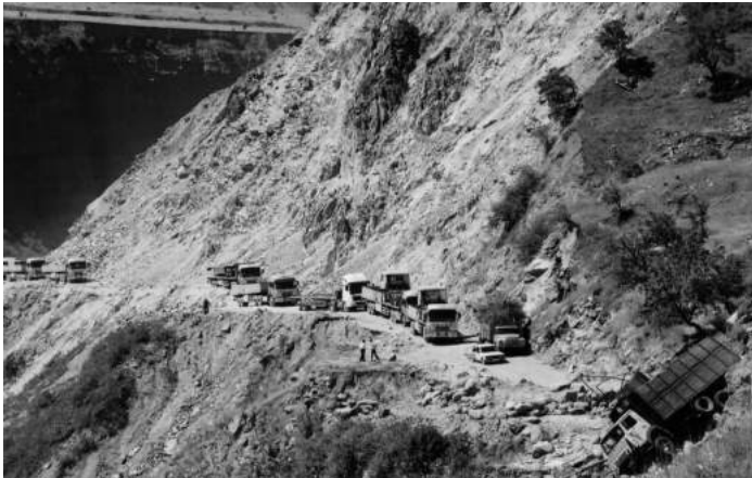
Авария. Дорога на Дангару
